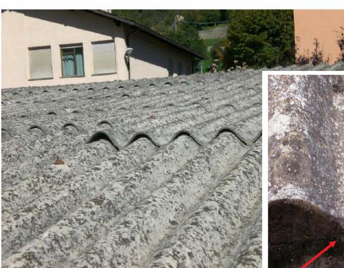
Foto 2 – Lastre ondulate di cemento-amianto
