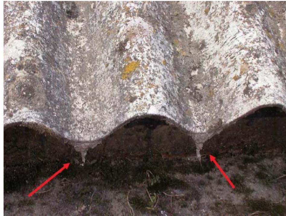
Foto 3 – Stalattiti filamentosose in corrispondenza dei punti di gocciolamento delle lastre ondulate di cemento-amianto.
